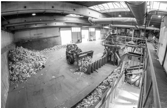
Mehrmals im Jahr bietet die AVR Kommunal kostenlose Führungen durch die Wertstoffsortieranlage Sinsheim an.
